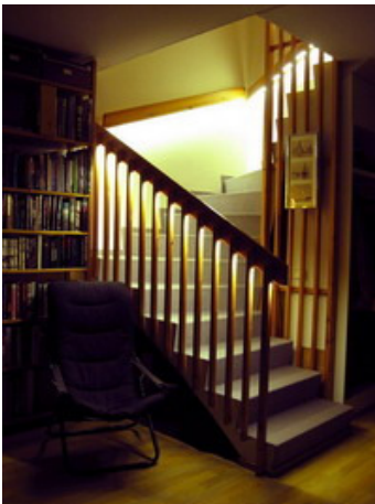
Portaikko. LED nauha on asennettu porraskaiteen alla. LED nauha voidaan asentaa myös askelmien alapintaan.
