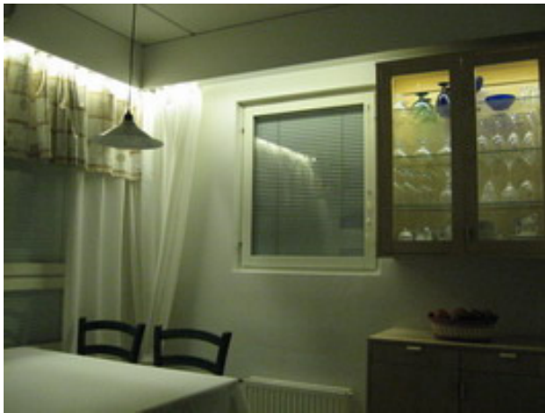
Verhokappa keittiössä. Verhokapassa ja kaapissa on käytetty samaa LED nauhaa.
